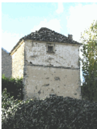
Le pigeonier de la rue du puits Chirot, couvert en laves. Sans doute, le bâtiment le plus ancien du village
