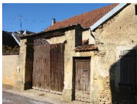
Portail en rue basse, portillon à droite
