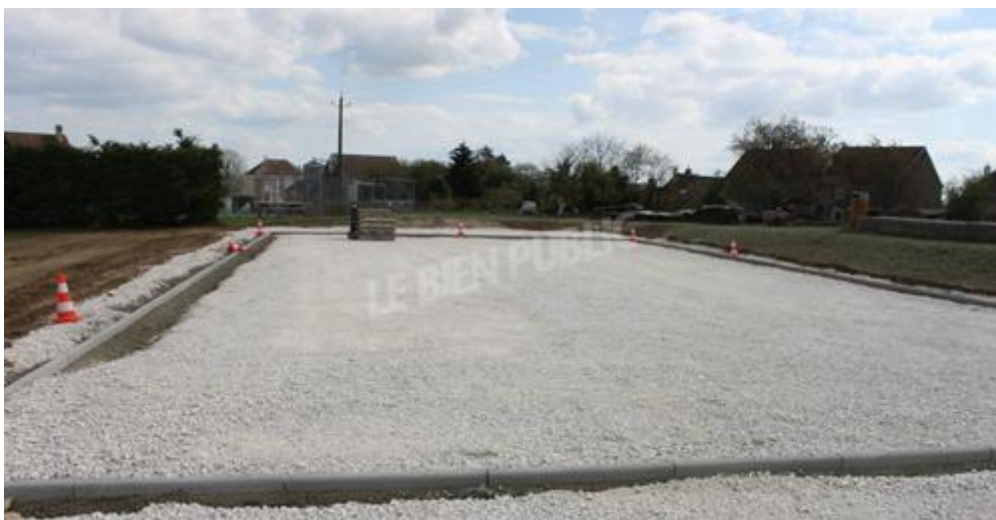
Les travaux du city stade ont débuté vendredi par la préparation du terrain. Photo LBP /An. R.
